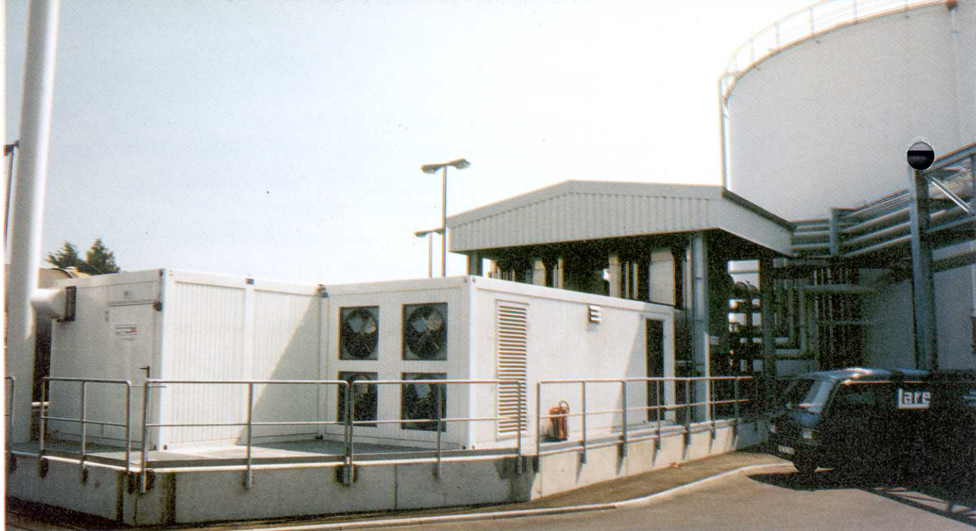
Terugwinning van benzine d.m.v. condensatie/Foto Raab Karche Stuttgart
