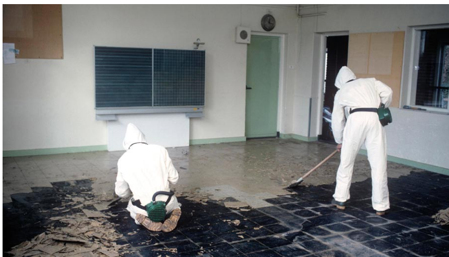
Asbestverwijdering op school
