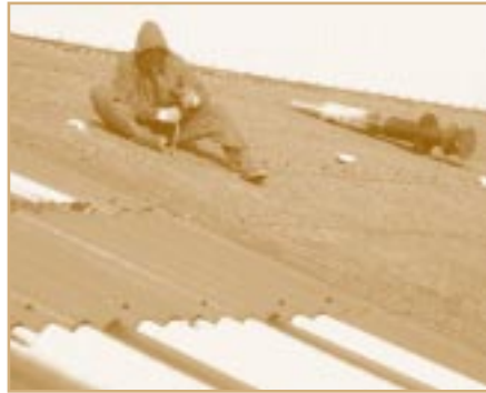
Verwijdering golfplaten van asbestcement
