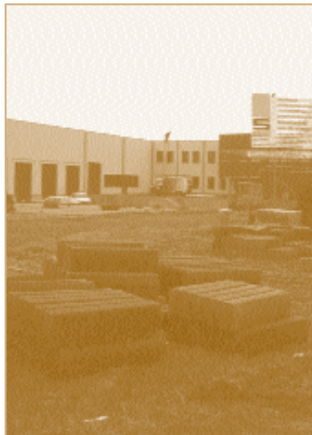
Een inrichting in aanbouw
