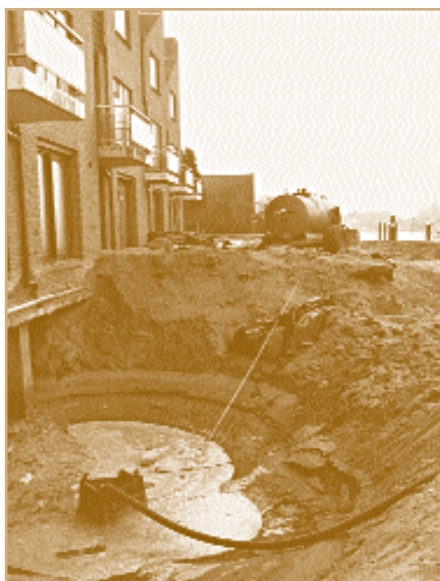
Bodemsanering in Krimpen aan de Lek
