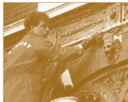
Gevelreiniging (foto: Stichting Bouwresearch)
