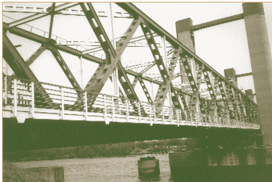
De Spijkenissebrug, voor een deel behandeld met VOS-arme verf (foto: VOM)
