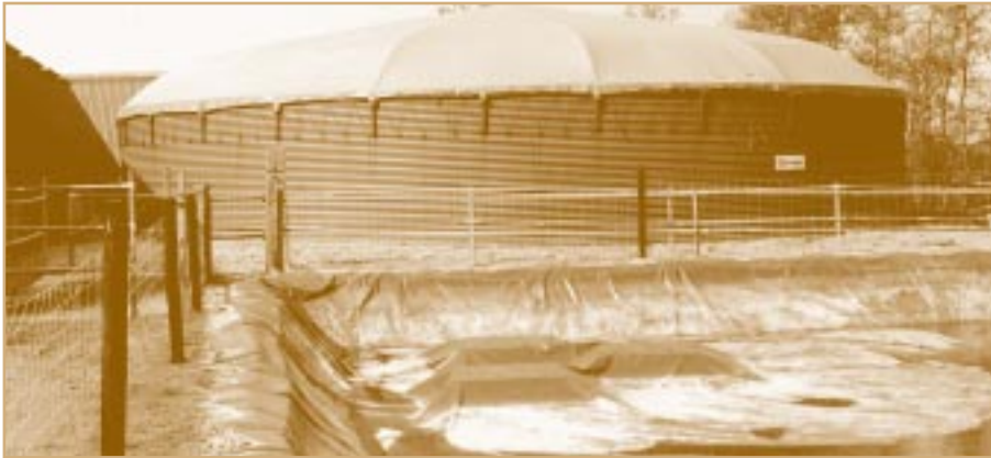
Vloeistofdichte voorziening voor mestopslag (foto: Kiwa)
