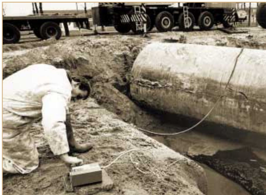
Ondergrondse tanks veroorzaken vaak bodemverontreiniging (foto: APS)
