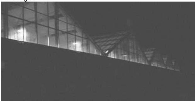
Gemeten breedkap-kas, gevel tot aan de goot afgeschermd, ophanghoogte lampen boven de goot.
