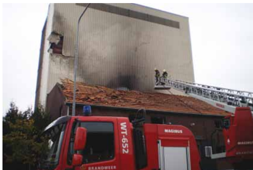
Een ontploffing in een mengvoerfabriek komt aan bod tijdens één van de presentaties.
