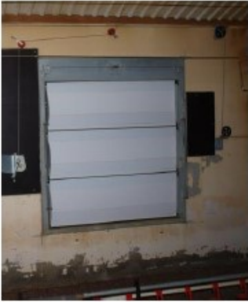
Voorbeeld van lamellen (Louvre-systeem) in zijgevel en luchttopvang in de nok.
