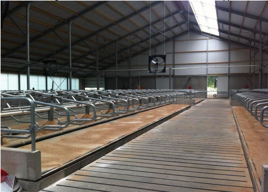
Foto van een ligboxenstal met de roostervloer met afdichtkleppen
