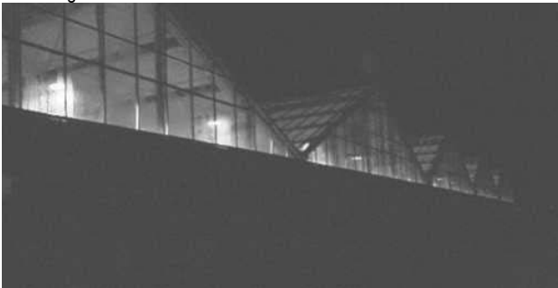
Gemeten breedkap-kas, gevel tot aan de goot afgeschermd, ophanghoogte lampen boven de goot.
