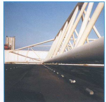
Maeslantkering (foto: ac-VOM)
