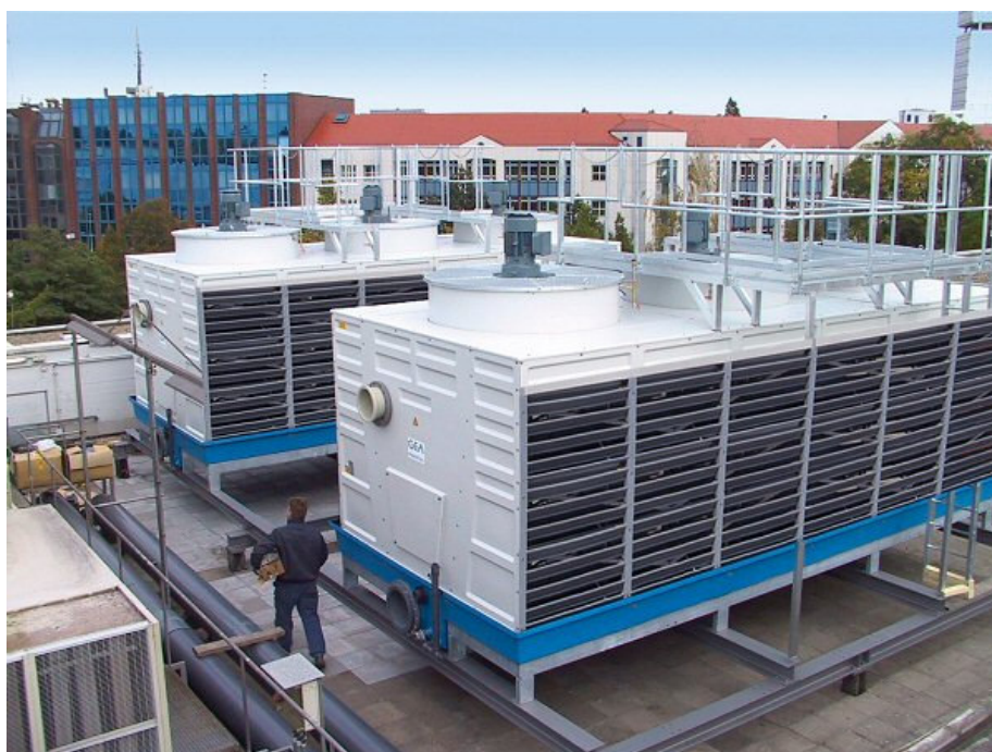
Figuur 3.2. Twee open recirculerende koeltorens
