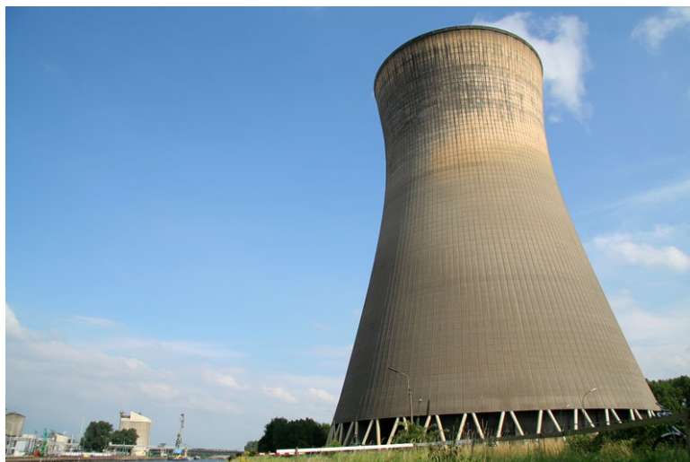
Figuur 3.5. Een koeltoren via het 'natuurlijke trek'- principe.
