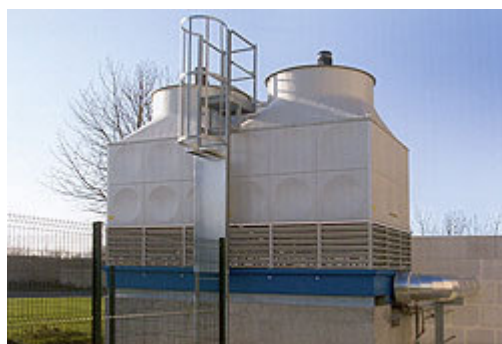
Figuur 3.2. Twee open recirculerende koeltorens
